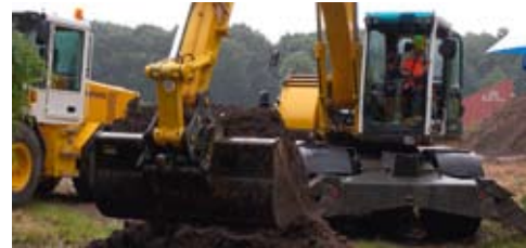
Wethouder Bart Claassen krom in juli in een graafmachine om met een eerste hap zand het startsein te geven voor de aanleg van het Kloosterpark.
